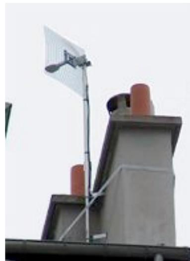
Vue générale et rapprochée d'une installation-type d'antenne Internet Ozone sur le toit d'un immeuble parisien. (Ici fixation par cerclage autour d'une cheminée).
