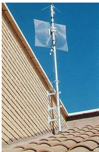
Une antenne d'Ozone fixée à un mât de type télévision
