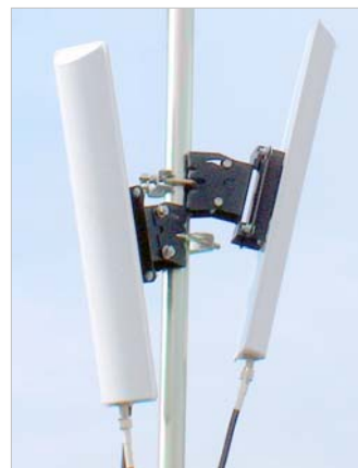
Vue rapprochée d'antennes d'émission Ozone.
